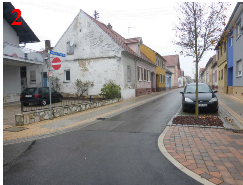
Achtung: Hier fehlt eine Überquerungshilfe!
